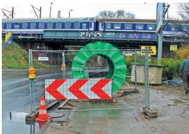
Fot. 10. Wprowadzanie taśmy przez otwarty właz
