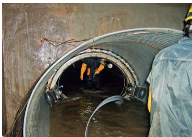
Fot. 6. Podawanie taśmy do nawijania
