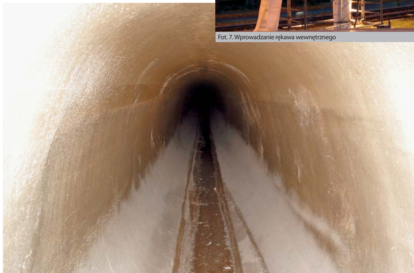
Fot. 8. Widok wnętrza zainstalowanej wykładziny CIPP
