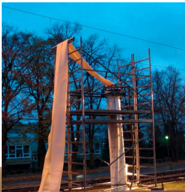
Fot. 7. Wprowadzanie rękawa wewnętrznego
